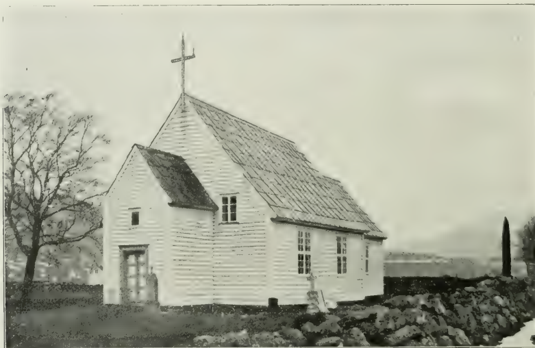
Fig. 255. Gjerde kirke bygget 1675 af Ole Vysem og Erik Nedre-Ekhaug.
